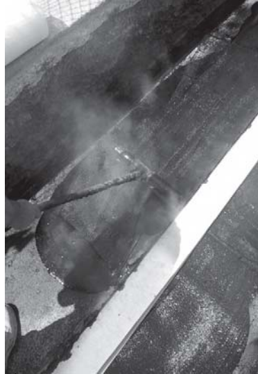
Aplicando la primera capa sobre el RedLINE.
