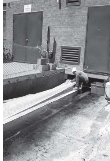
Colocando la membrana de estructura reforzadora sobre la primera capa.
