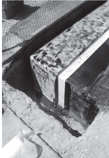
La estructura reforzadora aplicada a un lado de la junta RedLINE (se muestra la terminación de la junta).
