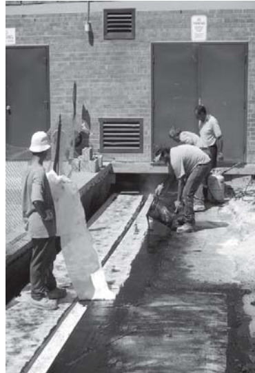
Colocando la membrana de estructura reforzadora sobre la primera capa.
