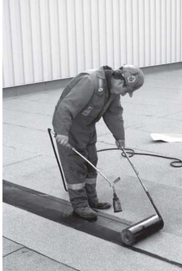
← La plancha de la tapa de betún modificado siendo soldada con soplete al FlamLINE.
