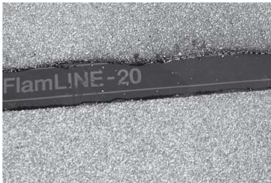
← La glándula FlamLINE se deja expuesta, note el sangrado a lo largo de los filos de la capa en tiras.
